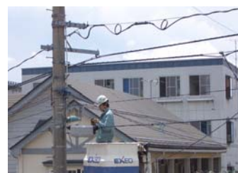
B フレッツ工事中の滝口君 事務所2Fから
